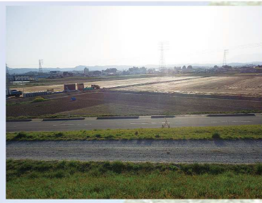
G-Bio 角田梶賀バイオマス発電所 土地造成工事
