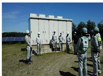
太陽光発電所 安全衛生パトロール
